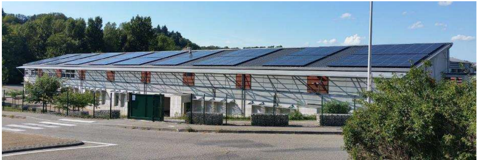
Exemple : 100 kWc sur un lycée isérois – modules espacés pour alléger la charge et éviter le renforcement de structure
